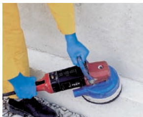
Očištění správního povrchu betonové konstrukce pomocí kotoučové brsky.
