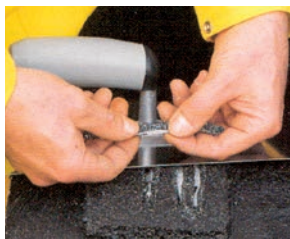
Kontrola stavu suchosti = kuličky EPS se musí dát přefříznout nožem. Tzn. dostatečná suchost stěrky pro aplikaci ochranných vrstev (nopová fólie, geotextilie, tepelná izolace) a následný zásyv zeminou. Zahnutí nevyschlé bituminové stěrky (kuličky EPS nelze přefříznout nožem) zeminou znamená mechanické poškození provedené hydroizolace.
