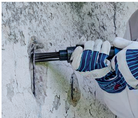
Jemné odstranění betonu vibračními jehlami
