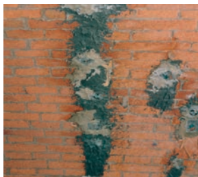
Uzavření trhlin epoxidovou maltou a kontrolní test soudržnosti pomocí odtrhových zkoušek.
