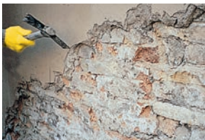
Starou, vlhkou a zasolenou omítku je nutno odstranit do výšky min. 80–100 cm nad viditelnou hranici vlhkosti. Okopanou omítku je nutno ihned odstranit z pracovního prostoru.
