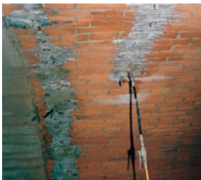
Výplň trhlin tlakovou injektáží.
