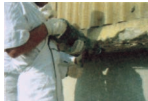
Ocelová výtzuž se musí zbavit rzi obroušením rotačním ocelovým kartáčem nebo brusným papírem.
