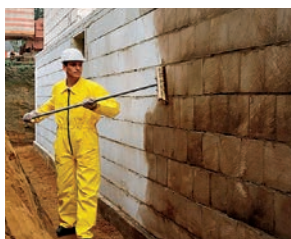
Penetrace podkladu – webertec 915 ; poměr ředění 1 : 10 s vodou.
