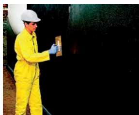
První vrstva bitumenová stěrka webertec 915 v tloušťce 2–3 mm. Celková tloušťka obou vrstev dohromady musí být 4 mm.
