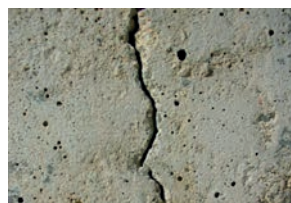
Svislá trhlina ve zdivu.
