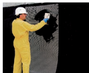
Vložení armovací výtzuže skelné tkaniny R131 se aplikuje pouze u tlakové vody a vysoké hladiny spodní vody.
