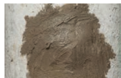
oprava materiálem webertec 935
