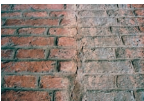
Svislá trhlina obvodové konstrukce statického původu.
