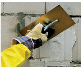
Vyspravení lunkrů a větších nerovností v podkladu pomocí malty webertec 933 .
