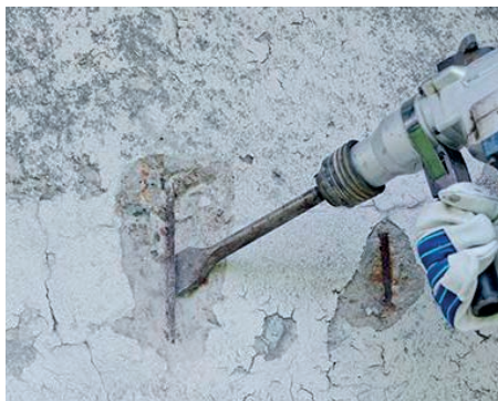
Hrubé odstranění betonu
