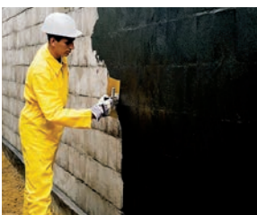
Základní vrstva (tzv. plíní) „Scratch coat“ bitumenová stěrka webertec 915 v tl. 1–2 mm.
