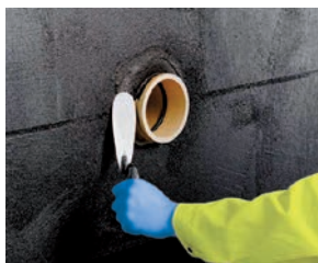
Řešení prostupů při netlakové vodě.
