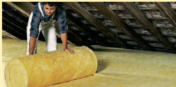
Zaizolované podlahy na půdě lze řešit jak nepochozí, tak s pochozí úpravou. (dále v katalogu)
