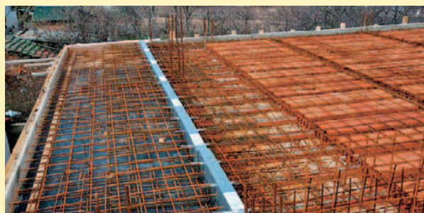
Přerušení tepelného mostu v rovině stropu pomůže zvýšit povrchovou teplotu podlahy a snížit riziko tvorby plísní.
