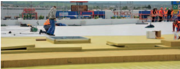
Největší výhodou pro použití výrobků z minerální izolace ISOVER pro ploché střechy je jejich unikátní kombinace tepelně izolačních, protipožárních a akustických vlastností. Další velkou výhodou těchto výrobků je jejich absolutní „snášlivost“ se všemi materiály, které se ve střešním pláště mohou vyskytnout – zejména základními hydroizolacemi tj. asfaltovými pásy a plastovými fóliemi.
