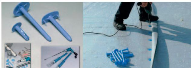
*Příklad kotvení fóliové hydroizolace teleskopickými kotvami.*
