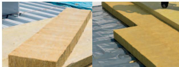
Lamely s kolmým vláknem ISOVER Lam může vzhledem k rozměru a nízké hmotnosti pokládat jeden pracovník samostatně. Tak dochází také ke zvýšení produktivity pokládky.
