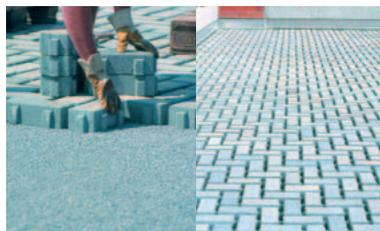
Jako vrstva štěrkového lože pro zámkovou dlažbu se doporučuje jemná, mrazuvzdorná drť o velikosti zrna 2/5 mm. Po zvlivování by měla být vrstva lože silná cca 50 mm. Požadovaný
