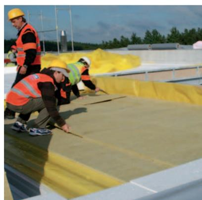
V systémech SG COMBI ROOF se jako požárně dělicí vrstva používají velkoformátové desky MW, které minimalizují počet spár a zvyšují produktivitu pokládky. Použití jiných typů izolantů je dle příslušného protokolu o klasifikaci požární odolnosti nepřípustné.
