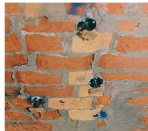
Odtrhové testy na soudržnost povrchové vrstvy zdegradovaného zdiva.
