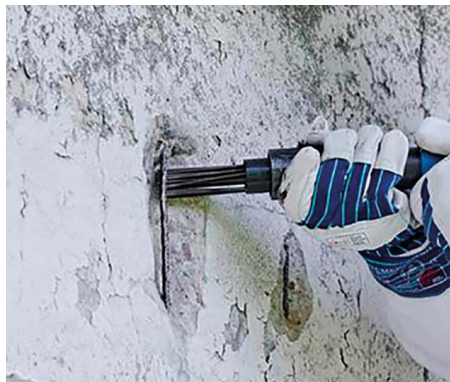
Jemné odstranění betonu vibračními jehlami
