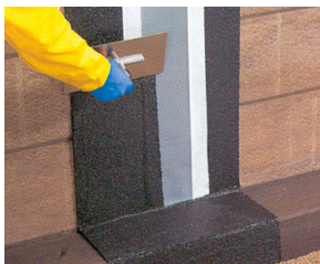
Řešení dilatací Dilatační fólie weberBE-14 (na objednávku).
