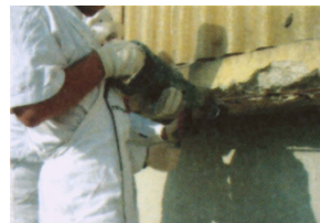
Ocelová výtluž se musí zbavit rzi obroušením rotačním ocelovým kartáčem nebo brusným papírem.
