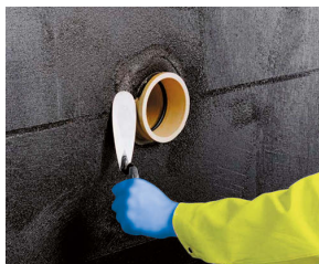
Řešení prostupů při netlakové vodě.
