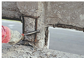
Zkorodovaný beton se odstraní až na pevný soudržný podklad. (Doporučujeme provádět kontrolu přídržnosti odtrhovými zkouškami)
