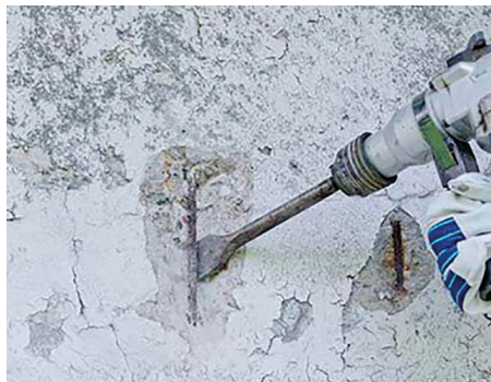
Hrubé odstranění betonu
