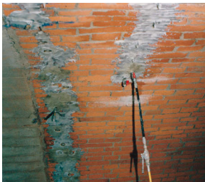
Výplň trhlin tlakovou injektáží.
