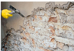
Starou, vlhkou a zasolenou omítku je nutno odstranit do výšky min. 80–100 cm nad viditelnou hranici vlhkosti. Okopanou omítku je nutno ihned odstranit z pracovního prostoru.
