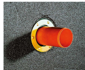
Řešení prostupu při tlakové vodě.
