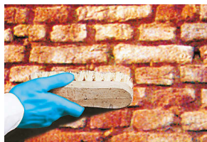
Spáry ve zdivu se vyškrábou do hloubky 1–2 cm a zdivo se očistí kartáčem.
