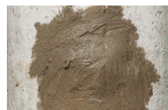
oprava materiálem webertec 935
