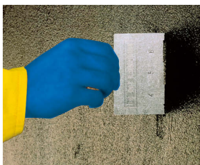
Dostatečná tloušťka nanesené bitumenové stěrky webertec 915 – 4 mm!
