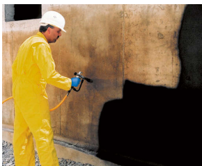
Druhá vrstva (tzv. konečná): Bitumenová stěrka webertec 915 v tloušťce 2–3 mm. Celková tloušťka obou vrstev dohromady musí být 4 mm.
