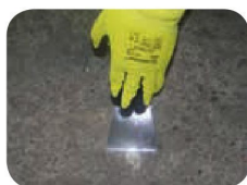
Staré zbytky cementu, sádky, lepidel nebo starých nátěrů nejlépe odstraníme mechanicky, např. špachtlí nebo škrabkou.
