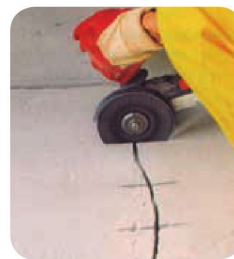
Příprava pro sešívání trhlin.
