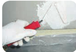
Obroušení povrchu stěrky na pohledových částech segmentu a penetrace povrchu penetrací weberpas podklad UNI . Technologická přestávka min. 24 hod.
