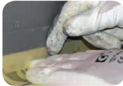
Vložení bandážního pásu weber.BE 14 v koutě mezi nášlapnou plochou a soklovou částí balkonového tělesa do hydroizolační hmoty terizol .
