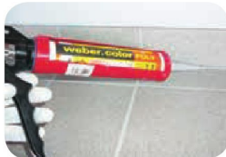
Vyměření koutové spáry a spár mezi dlaždicemi a okapovým plechem těsnícím tmelem webercolor POLY .
