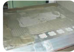
Přeplepení izolačního pásu Kerdi-Keba 150/100 přes perforaci v okapovém plechu jednou polovinou do lepidla weberfor duoflex , přičemž druhá polovina pásu Kerdi-Keba je vložená do nanášené hydroizolační hmoty terizol , která je rozprostřena na nášlapné ploše balkonového tělesa ocel. Hladitkem se zubí 4x4 mm. Technologická přestávka min. 24 hod.
