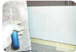
Nanesebí finální vrstvy pastovité omítky weberpas extraClean se zmy 2 mm - točené.
