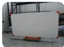
Ukázka přepravy a manipulace s ultratenkými velkoplošnými formáty dlaždic.
