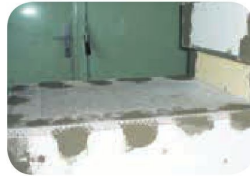
Zastěrkování čelních a bočních ploch izolantu a extrudovaného pásu stěrkovým lepidlem weber.therm technik současně s vložením weber.roh kombi PVC a skleněné síťoviny WT 131 po celých plochách.
