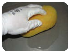
Starý nátěr je třeba odmastit např. saponátem s vodou a zároveň odstranit zbytky vosku alkalickým roztokem (soda + voda).
