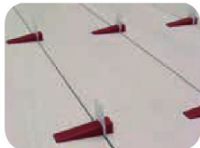
Ukázka zafixování a vyrovnání velkoplošných keramických desek.
