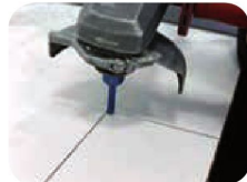
Ukázka řezání a vrtání otvorů pomocí speciálních nástrojů.
