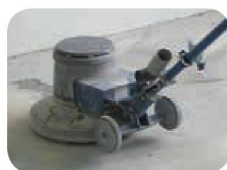
Je třeba odstranit i zbytky nátěrů, a to nejlépe škrabkou (u větších ploch obroušením nebo otruskáním). Pokud je povrch hloubkově narušen nebo znečištěn (oleje, rozpouštědla), je nutné odřezání podkladu.
