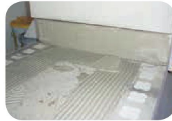
Osazení weberbalkonového profilu, jeho spojení weberspojkami za pomoci tmele webercolor POLY .
