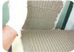
Lepení sliatých dlaždic typu Taurus rozměru 20x20cm pomocí lepidla weberfor duoflex oboustranným lepením, včetně nalepení soklových dlaždic. Technologická přestávka min. 24 hod.
