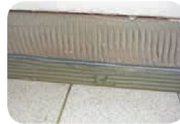
Vyčištění spár mezi dlaždicemi, vložení weberšeráňového provazce v koutě mezi nášlapnou plochou a soklem a zaspárování spár spárovací maltou webercolor comfort .
